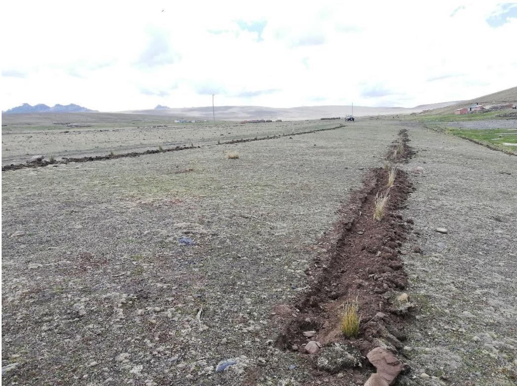
Construcción de zanjas de infiltración con trasplante de especies nativas
