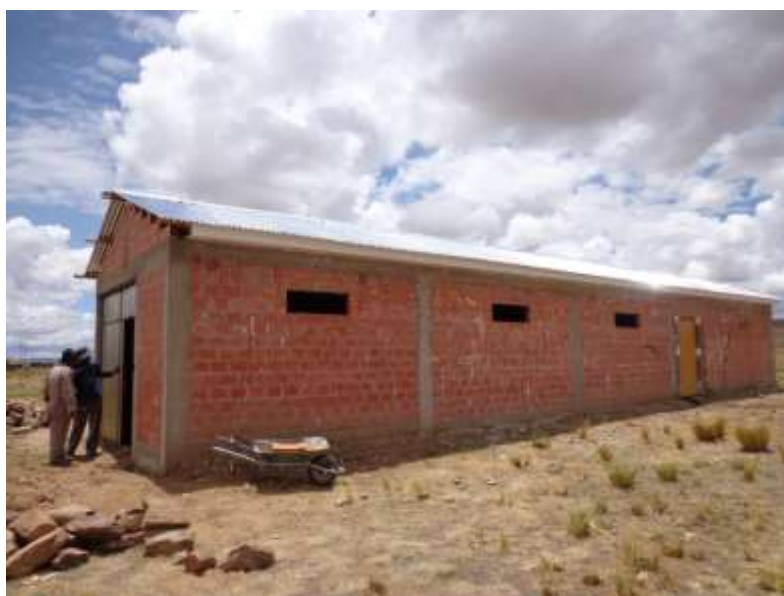
Henil construido: Comunidad Hilata San Jorge - Viacha
