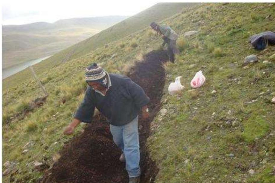
En una hectárea con 2.500 metros lineales de zanjas de infiltración, se cosecha e infiltra 75 m<sup>3</sup> de agua por hectárea, en una temporada de lluvia (PUQ 1999 - 2001).
